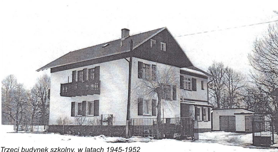
Trzeci budynek szkolny, w latach 1945-1952
